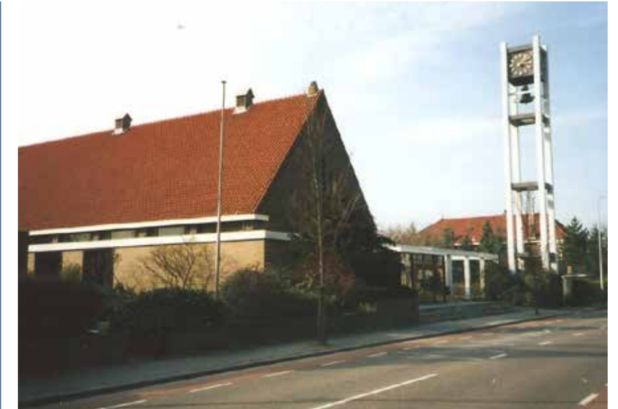
De Bethelkerk in Rijnsburg werd in 1928 gebouwd. In 2010 was er de laatste kerkdienst. In het najaar van 2016 is de kerk gesloopt ten behoeve van woningbouw. Beeld: Reliwiki.
