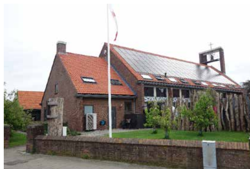
Zonnepanelen op het dak van de voormalige Petrakerk
